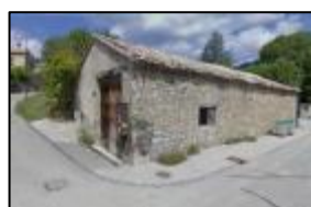
pente du toit faible
